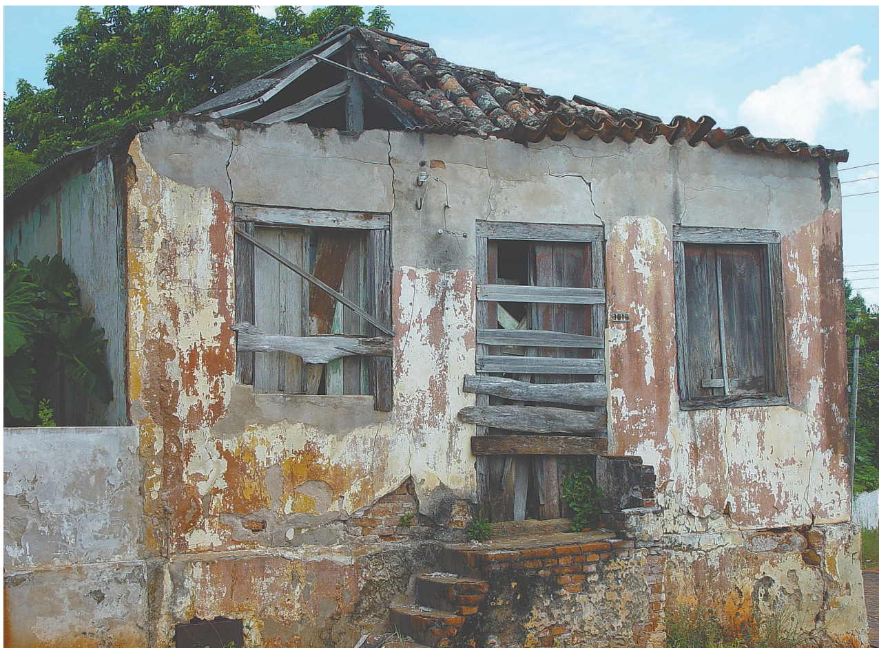
Casa da Aldeia é um dos prédios mais antigos ainda de pé, tido como um dos símbolos da construção urbana de Cachoeira do Sul
