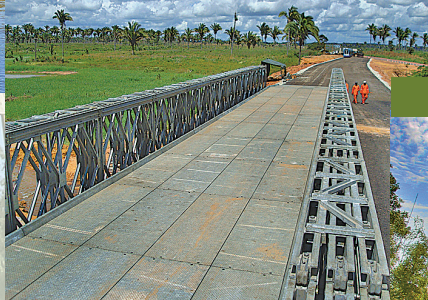
Apoio à Defesa Civil no Maranhão Ponte Compact 200
