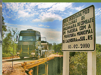
Ponte sobre o Arroio Forqueta
