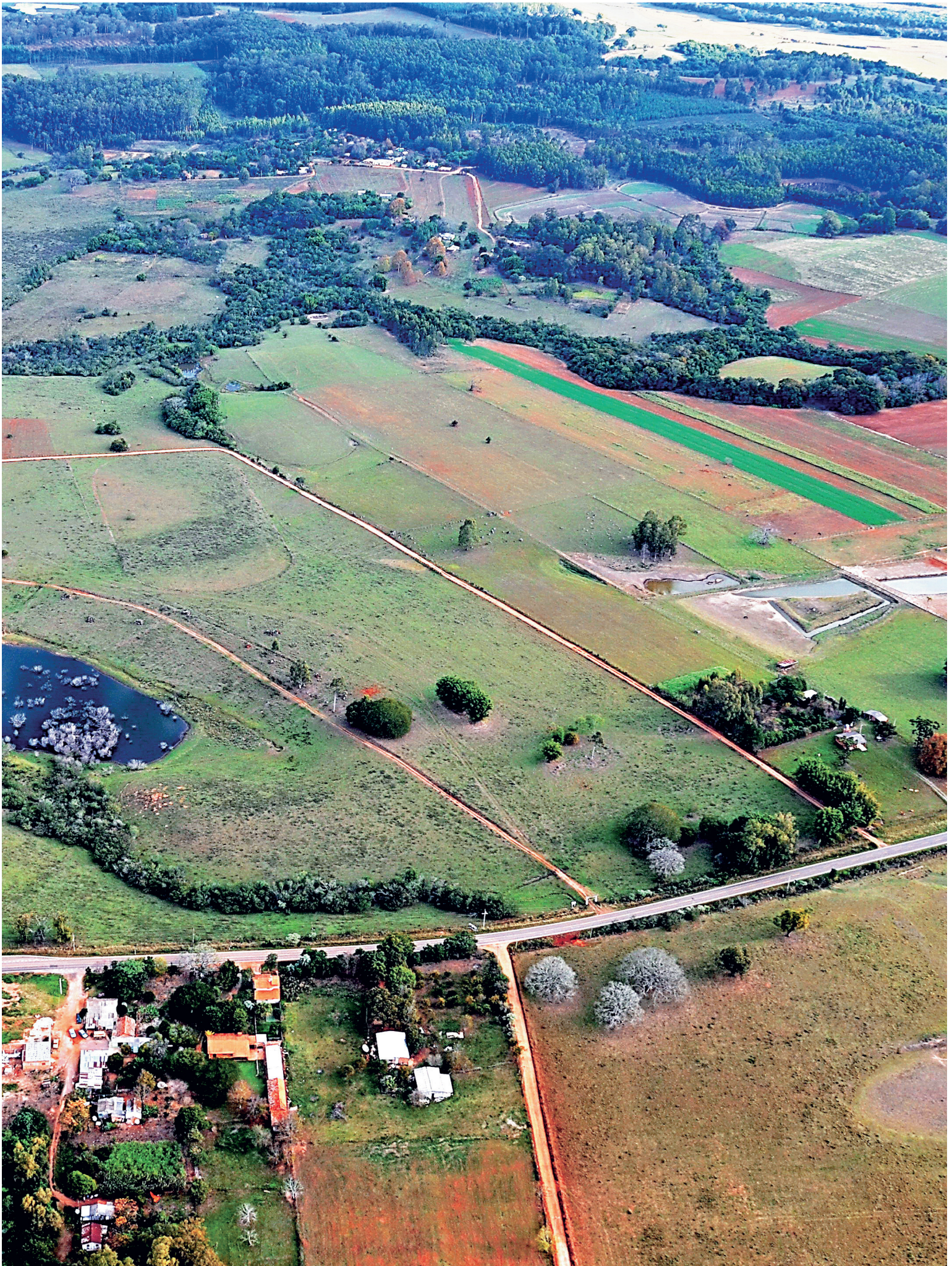
O campus da UFSM/Cachoeira será construído em uma área de 88 hectares comprada e cedida pela Prefeitura. As obras devem começar ainda em 2014, com investimento de R$ 100 milhões do MEC
