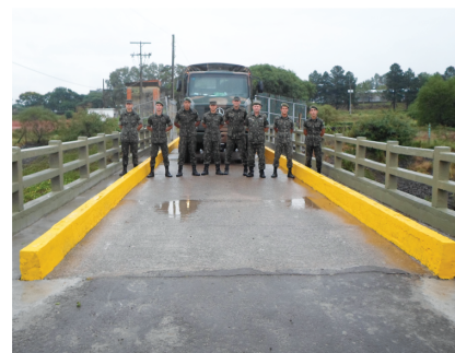
Reforma na Ponte sobre o Arroio Cadena, Santa Maria, RS
