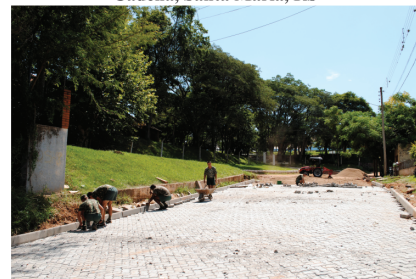
Calçamento da Rua Marques Ribeiro
